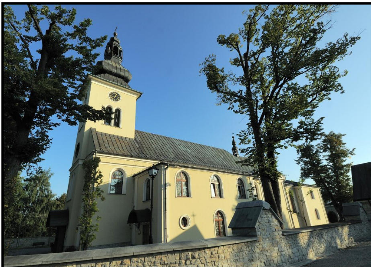
Kościół p.w. Nawiedzenia NMP w Hałcnowie
