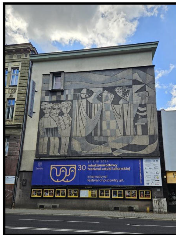
Sgraffito na budynku „Baniałuki” przy ul. 3 Maja
