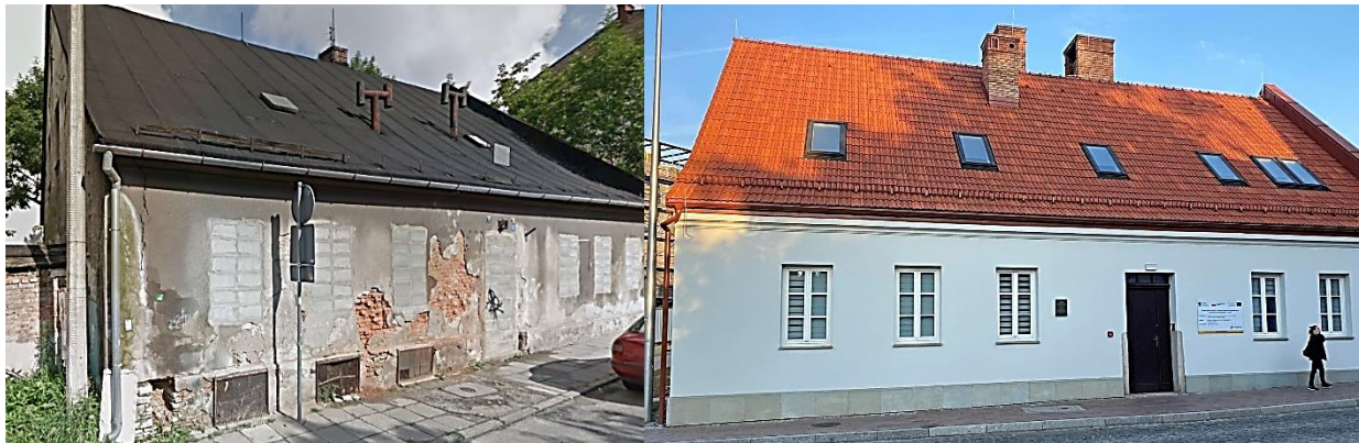
Fot. Budynek przy ul. Cieszyńskiej 18, przed ... i po remoncie. Fot. www.google.pl , zasoby COP
