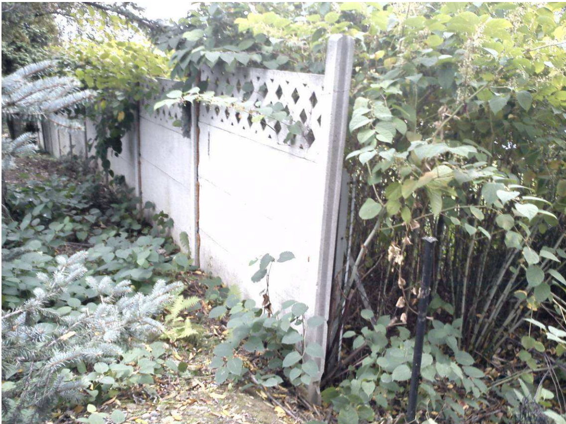
Fot. 3 – Miejsce łączenia istniejącego ogrodzenia betonowego z istniejącym ogrodzeniem z siatki
