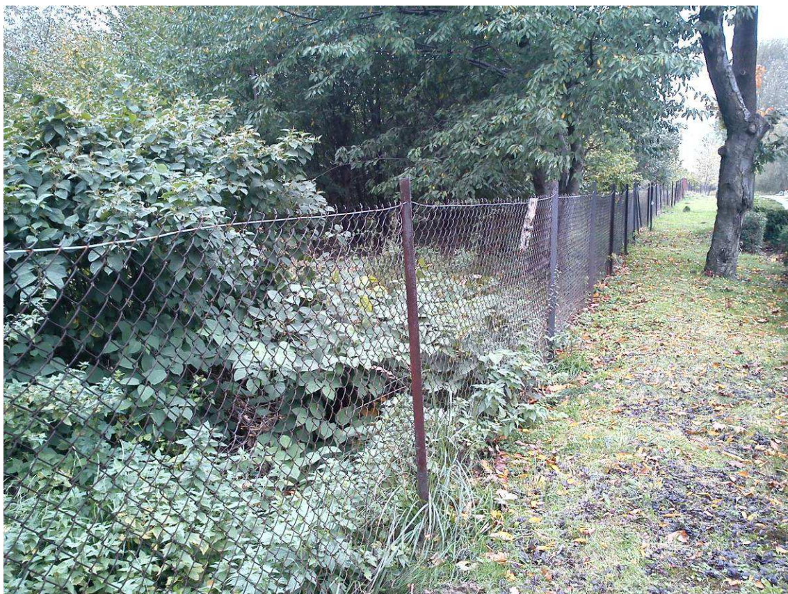
Fot. 7 – Istniejące ogrodzenie z siatki
