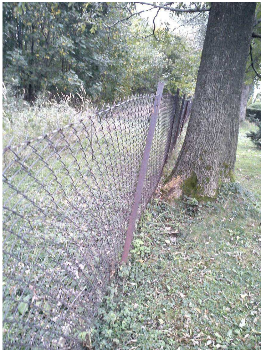
Fot. 6 – Istniejące ogrodzenie z siatki
