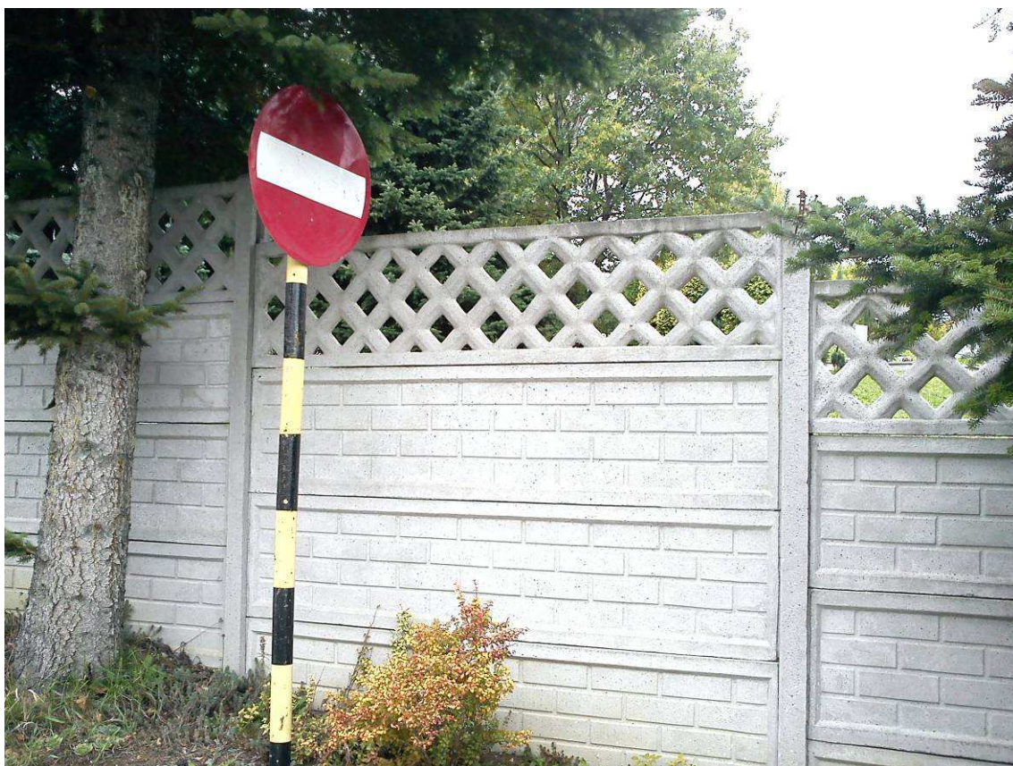
Fot. 2 – Istniejące ogrodzenie betonowe
