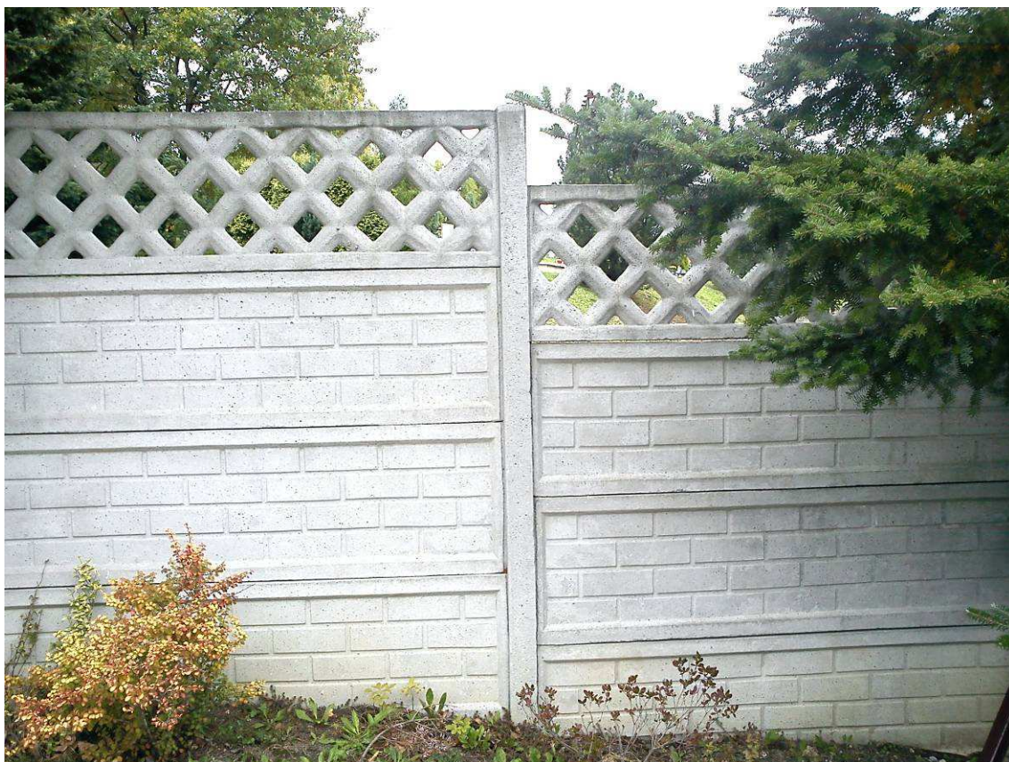
Fot. 1 – Istniejące ogrodzenie betonowe
