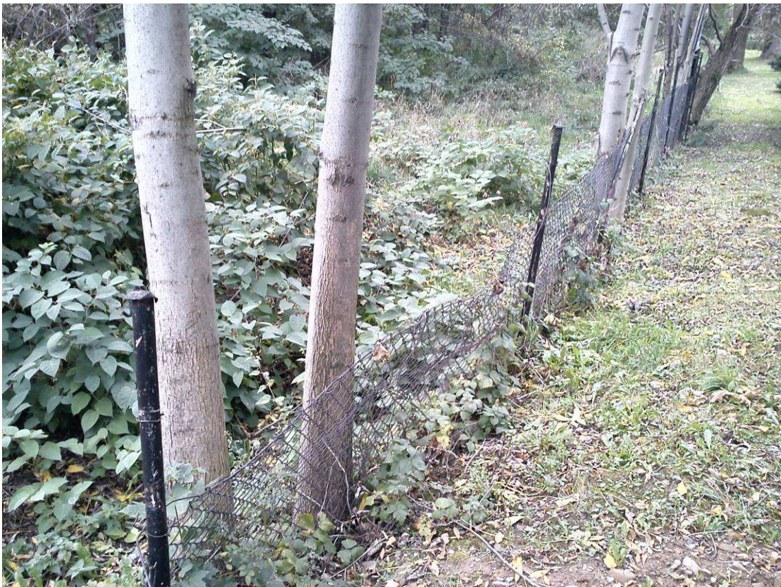
Fot. 4 – Istniejące ogrodzenie z siatki
